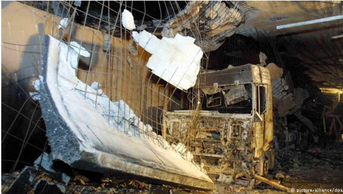
Abbildung 2: Brandereignis im Gotthard Tunnel [Quelle: www.dw.com ]
